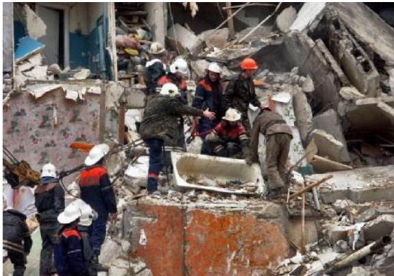
Рис. 7.3. Аварійно-рятувальні роботи під завалів
