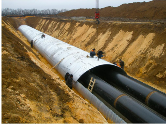
Рисунок 7.7 – Футляр для магістрального водопроводу (аеропорт м.Донецьк)
