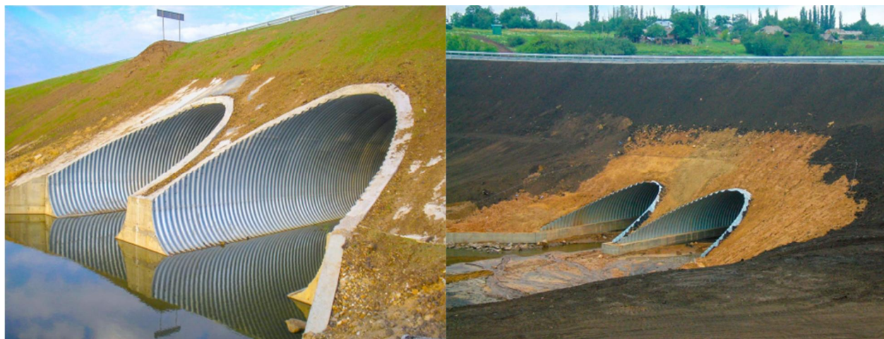
Рисунок 7.9 – Водопрпускні труби на автомобільній дорозі Н-14 Олександрівка – Кропивницький – Миколаїв
