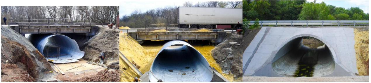
Рисунок 7.10 – Реконструкція (гільзування) мостового переходу на автомобільній дорозі Київ – Луганськ – Ізварине
