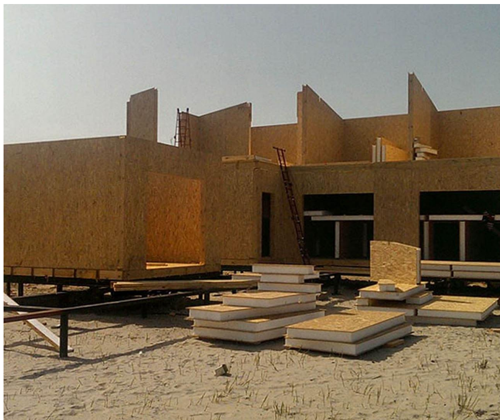
Рис. 3.1. Панелі які використовуються для будівництва модульних готелів
