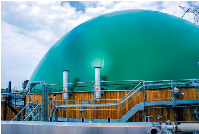
Рис. 6. Біогазова установка яка працює на відходах харчової промисловості [4]
