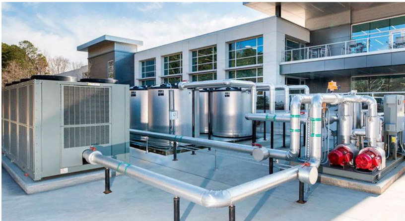
Рис. 5. Установка енергетичного акумулювання холоду для забезпечення технологічних операцій підприємства харчової галузі [11]
