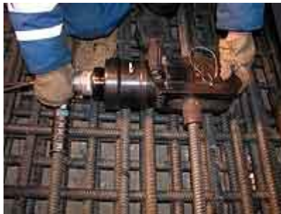
Рис. 6.10. З'єднання муфти з арматурою гідравлічним пресом
