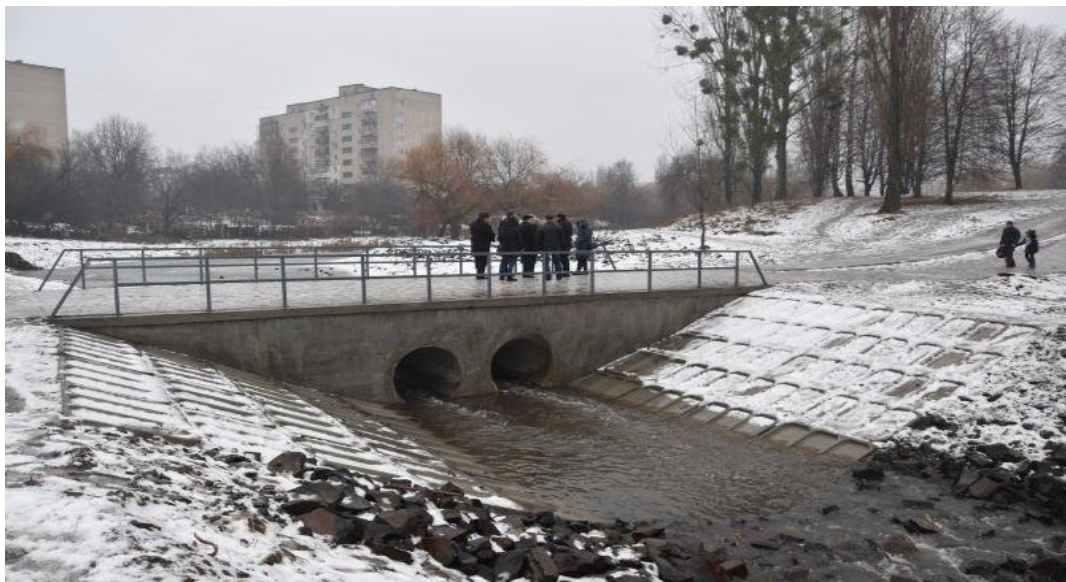
Рисунок 4.1. Споруда гідротехнічна (мостовий перехід з шлюзовою камерою)
