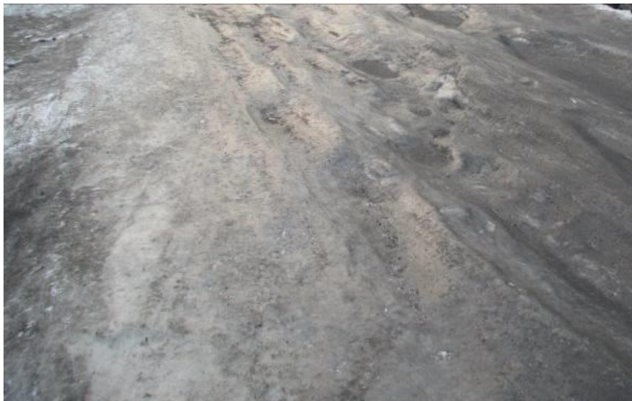
Рисунок 7.5 – Шорстка поверхня дорожнього після взаємодії з нагрітим відсівом
