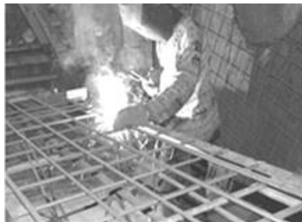
Рис. 4.3. Пост зварювання арматурного каркасу вручну
