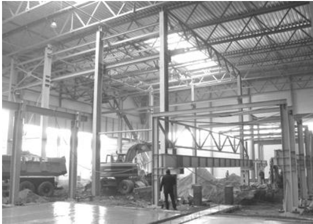
Рис. 6.1. Промислова будівля з металевих каркасів
