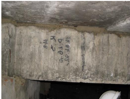
Рис. 7. Змонтована збірна залізобетонна колона в якості ригеля (ряд Е, осі 29 – 30)
