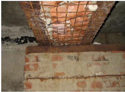
Рис. 5. Ексцентричне розміщення металевої балки 2 □ №30С – ряд Г, вісь 35, закладання цеглою міжбалкового простору
