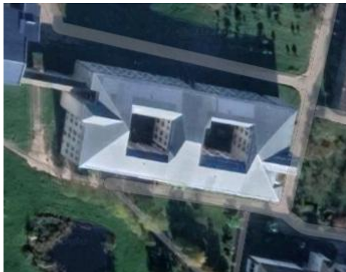
Рисунок 1.1 – Корпус «В» Луцького національного технічного університету (Google Maps)
