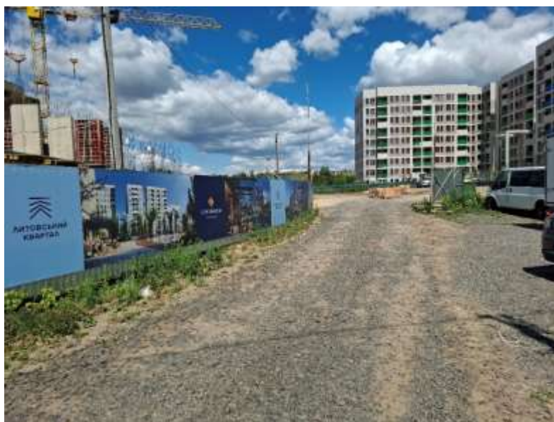
Рис. 2.1. Загальний вигляд будівництва ЖК Литовський квартал, травень, 2026 р.
