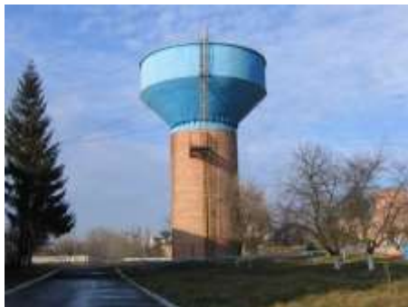
Рис. 3.5. Напірна башта станції знезалізнення води
