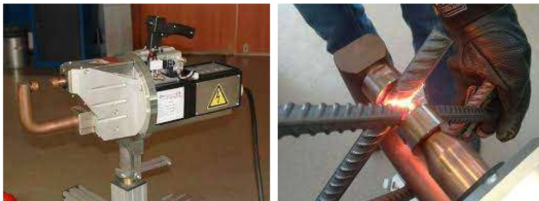
Рисунок 2.2 – Зварювання арматури в нахлест
