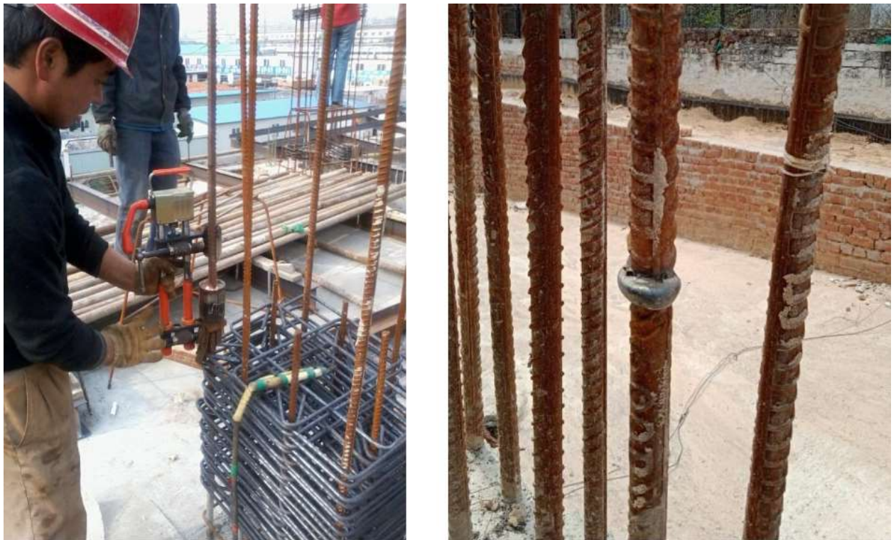
Рисунок 1.1 – З'єднання арматури контактним зварюванням
