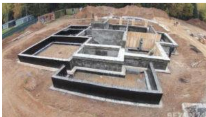
Рисунок 1.2. Монолітний стрічковий фундамент
