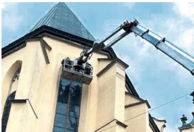
Рис. 12.2 Виконання РРР по фасадах, м. Львів: а) монтаж інвентарної риштовки; б) виконання робіт з захисту вітражів за допомогою телескопічної вишки
