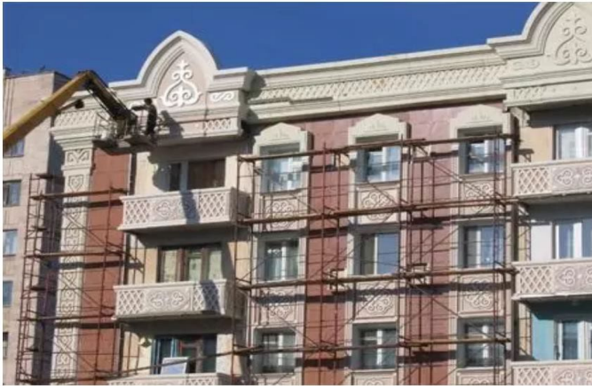
Рис. 1.1 – Реставрація фасаду житлової будівлі
