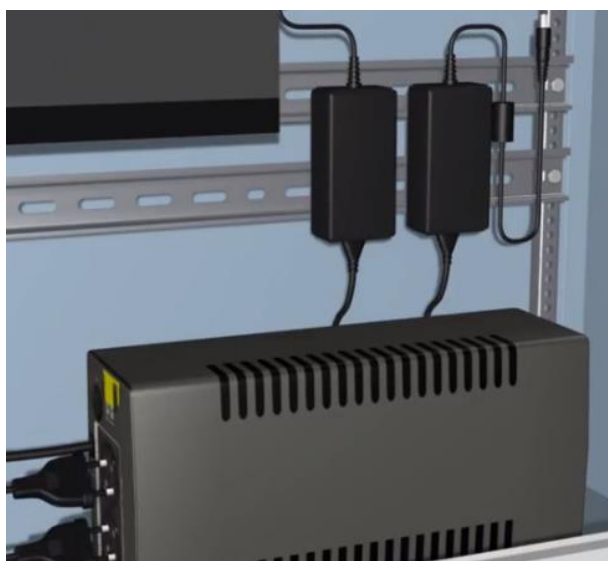
Рисунок 6.20 – Приклад встановлення на дін-рейці блоки живлення PoE комутатора і мережевого реєстратора
