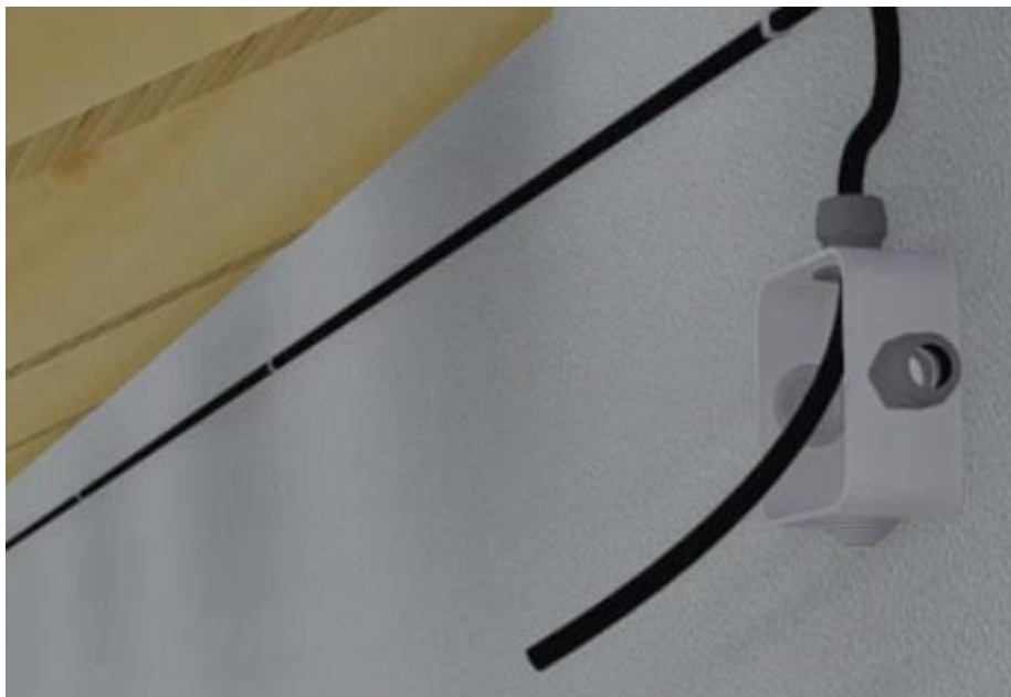
Рисунок 6.14 – Прокладання гофри до монтажної коробки
