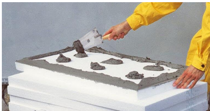
Рисунок 3.3 - Маяковий спосіб нанесення клейової суміші
