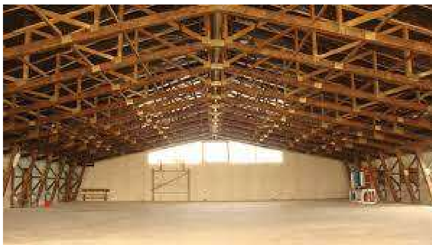
Рис.1.4. Склад мінеральних добрив з несучими дерев'яними конструкціями
