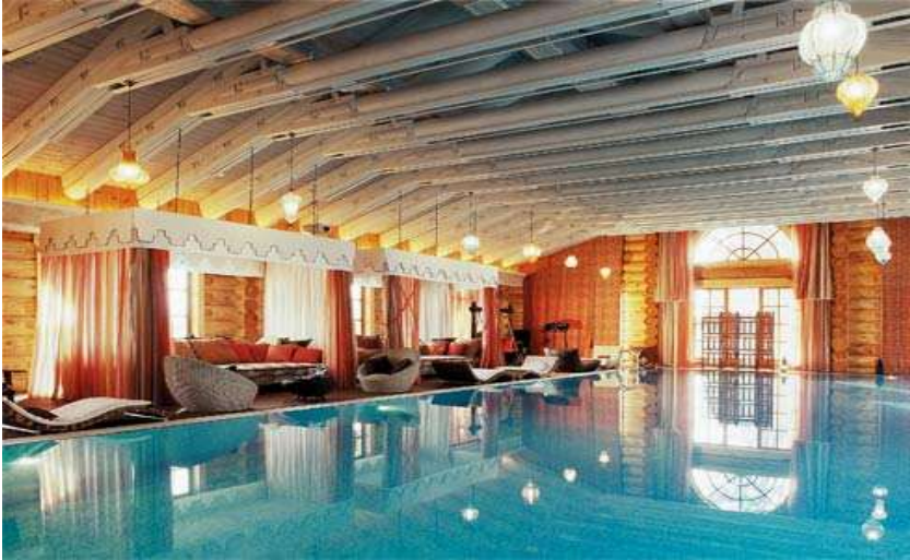
Рис. 1.2. Басейн з несучими дерев'яними конструкціями
