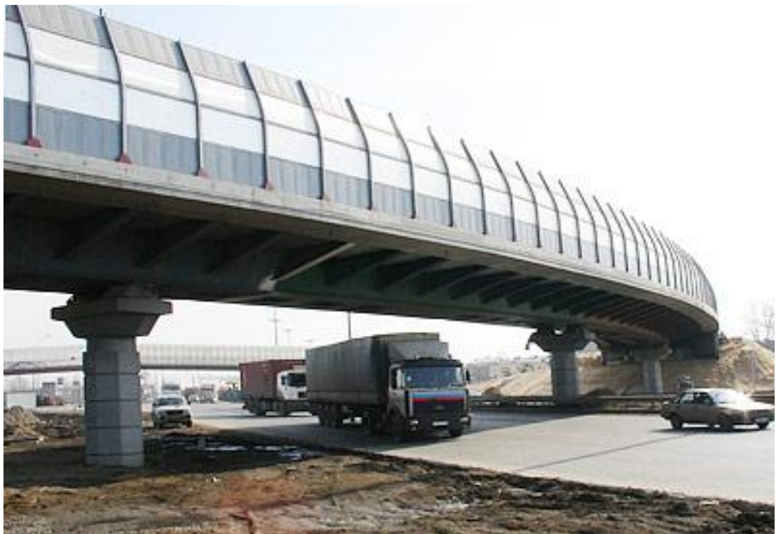
Рис. 6.5. Шумозахисні споруди різних конструкцій
