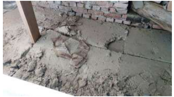
Рис. 6.3. Стан утеплювача на холодному горищі
