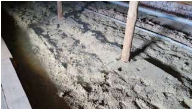
Рис. 6.3. Стан утеплювача на холодному горищі
