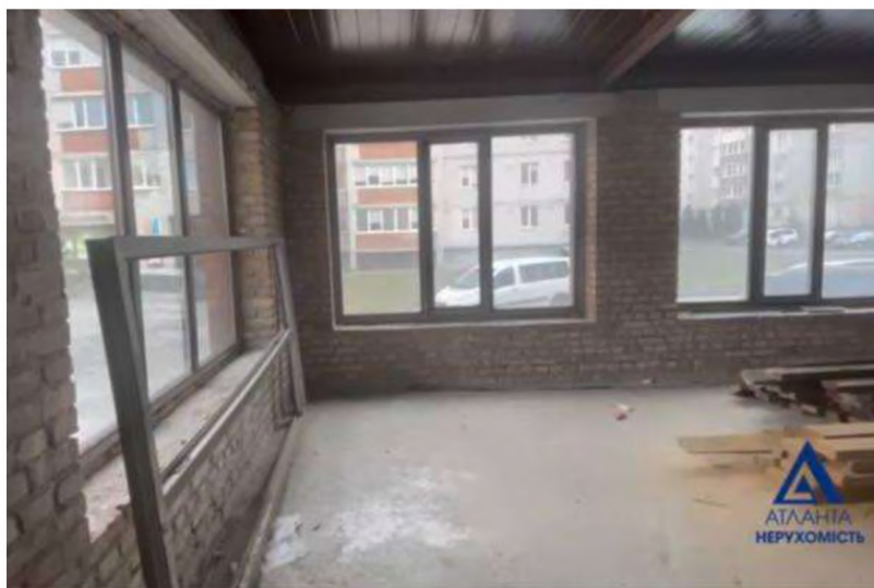
Рис. А.4.2. Вигляд приміщення на етапі замірів об'єкту
