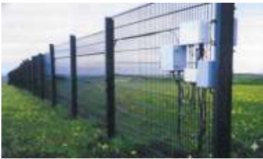
Рисунок 2.37 – Приклад та узагальнена схема монтажу сповіщувача
