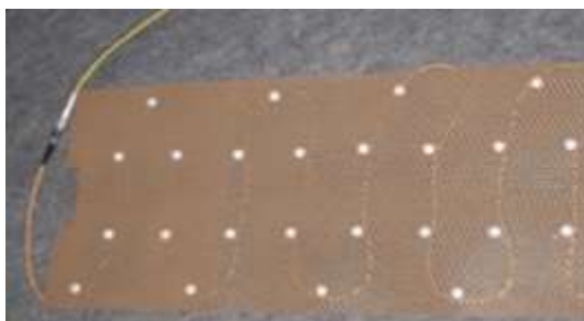
Рисунок 2.19 – Монтаж трибоелектричного кабелю СЗВ на сітці
