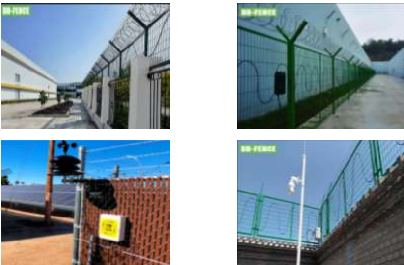
Рисунок 2.35 – Приклад монтажу вібраційного сповіщувача
