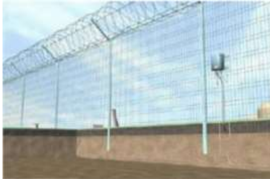
Рисунок 2.18 – Прокладання чутливого елемента для визначення підкопу
