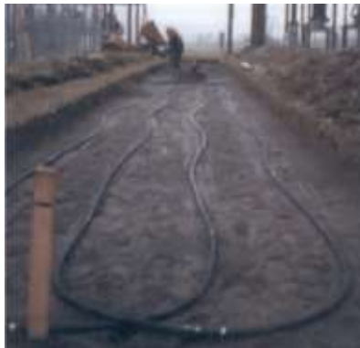
Рисунок 2.29 – Укладання чутливих елементів манометричного сповіщувача
