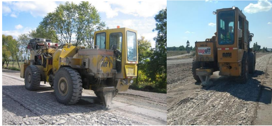
Рисунок 3.1 Віброрезонансною технологія машиною RB-500 від компанії RMI
