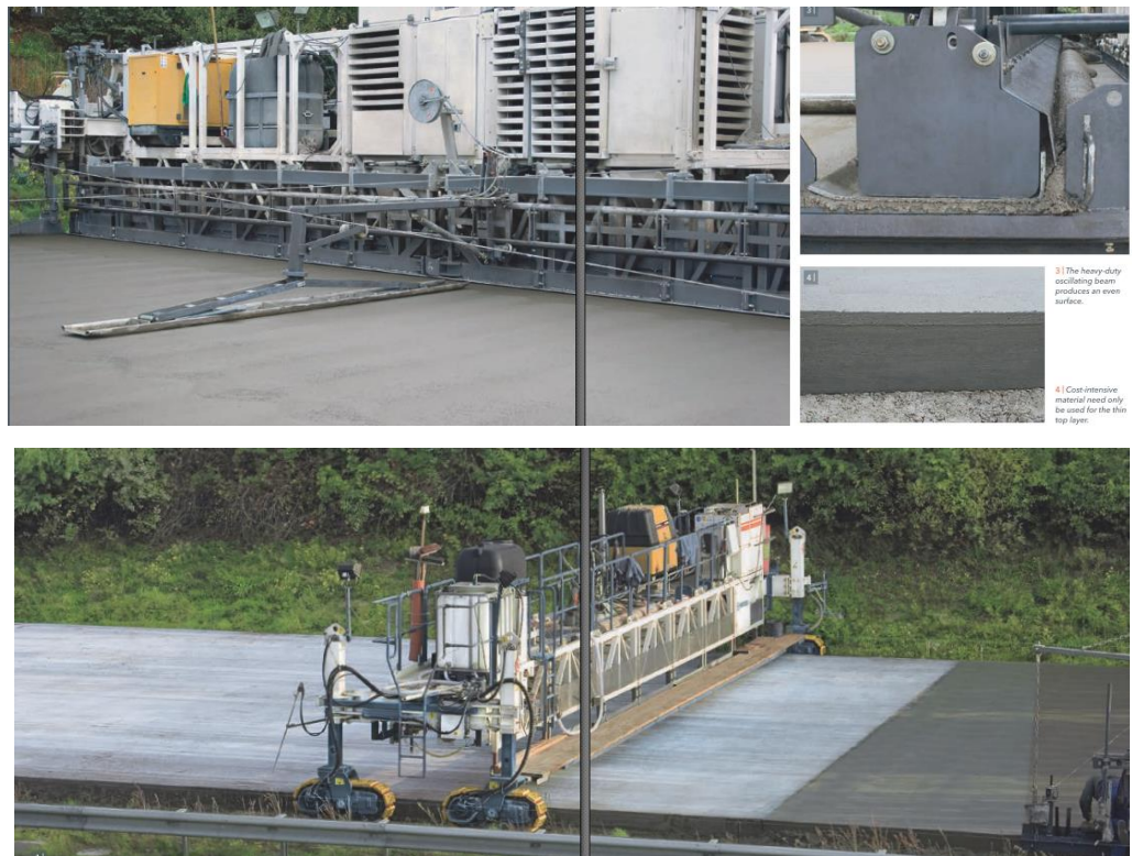
Рисунок 3.3 Технологія укладання ЦБ укладальником Wirtger марки PS-1500
