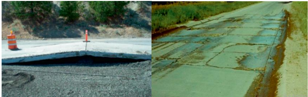
Рисунок 1.4. Стан ЦБ покриття
