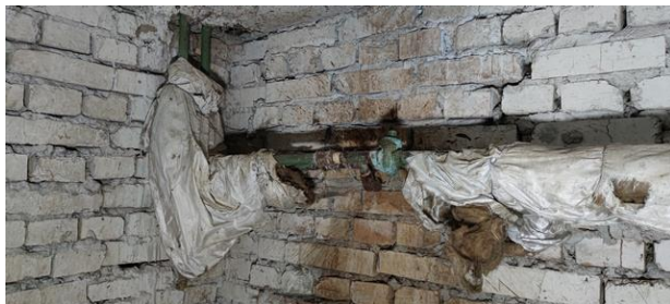
Рис. 2. Стан значної кількості існуючих трубопроводів
