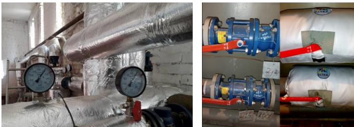
Рис. 4. Приклад якісного утеплення трубопроводів та фланцевої арматури
