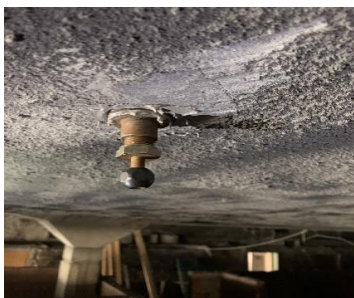
Рис. 4. Підготовлений зразок для оцінки адгезійної міцності торкретбетону
