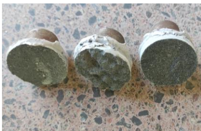
Рис. 6. Дослідні зразки із шарів торкрет бетону перекриття
