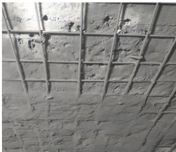
Рис. 2. Загальний вигляд поверхні при нанесенні шару торкретбетону
