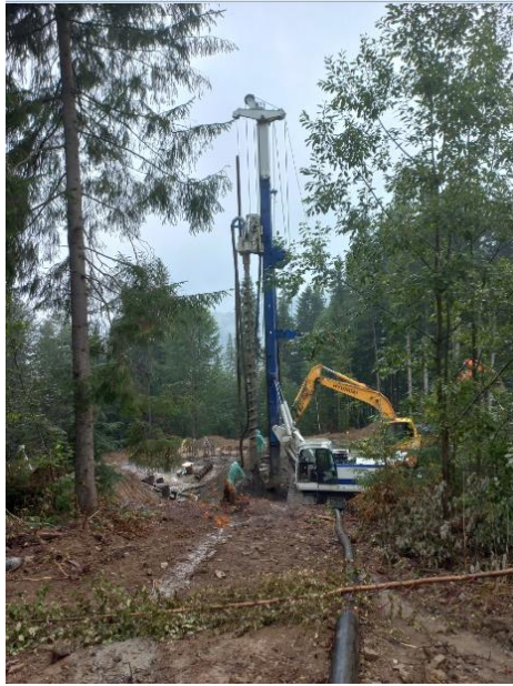
Рис. 1 Влаштування буронабивних паль по технології CFA
