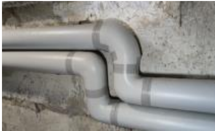
Рис. 6. Механічний захист утеплювача
