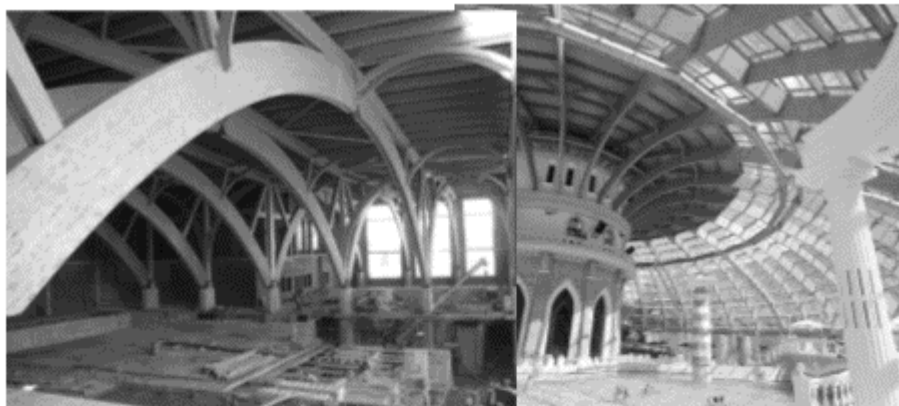
Рис. 6. Будівництво спортивно оздоровчих комплексів з клеєних арочних конструкцій.
