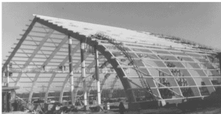
Рис. 4. Склад з клеєних дерев'яних арок прольотом 60 м, висота - 22 м
