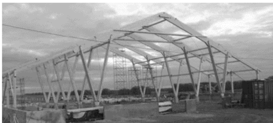
Рис. 5. Будівництво сільськогосподарських об'єктів.
