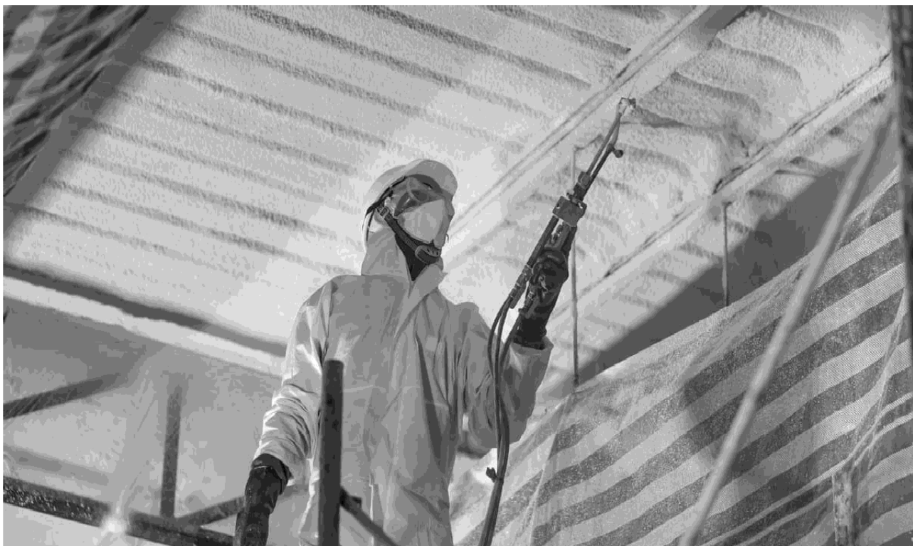
Рисунок 6.5 - Нанесення штукатурного покриття з використанням індивідуального захисту.
