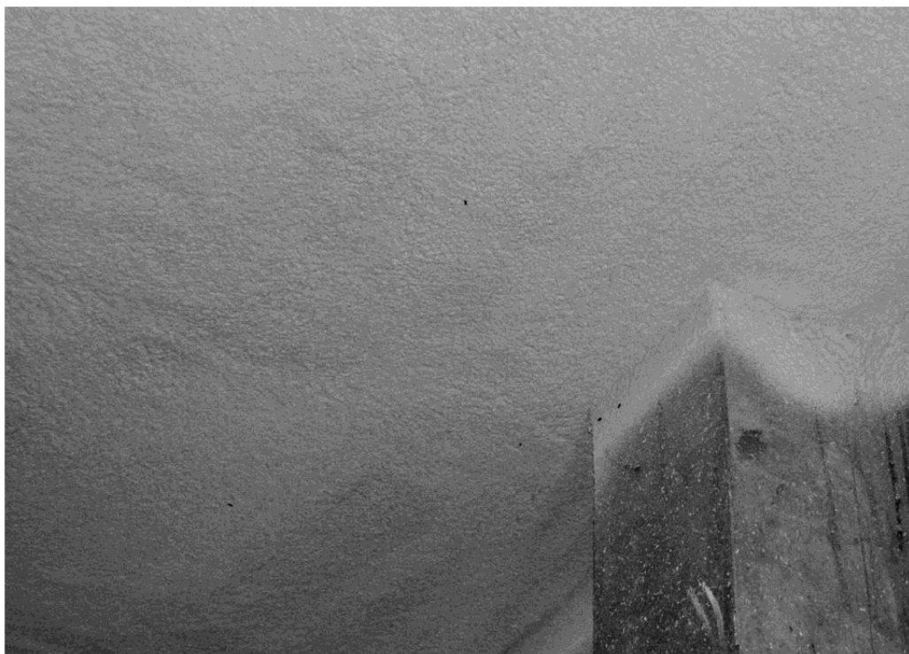
Рисунок 6.4 - Вигляд нанесеної вогнезахисної штукатурки.
