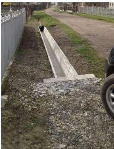
Рисунок 7.8 – Лотки укріплення каналів
