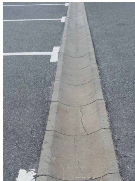
Рисунок 7.12 – Приклад пошкодження бетонних лотків водовідведення на автостоянці в м. Краків (Польща)
