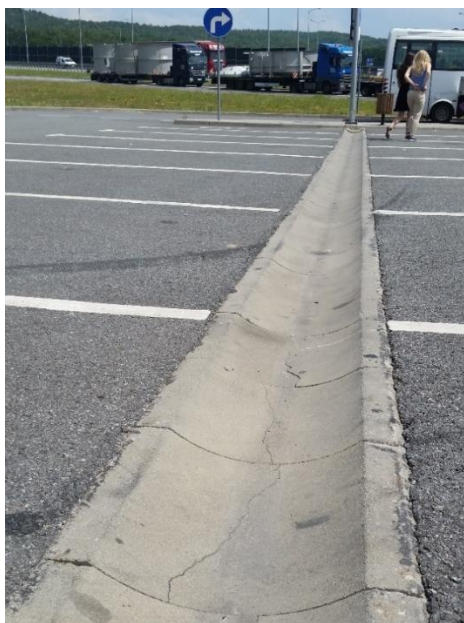
Рисунок 7.12 – Приклад пошкодження бетонних лотків водовідведення на автостоянці в м. Краків (Польща)
