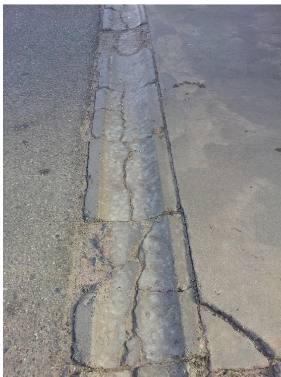
Рисунок 7.12 – Приклад пошкодження бетонних лотків водовідведення на автостоянці в м. Краків (Польща)
