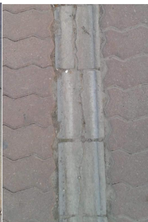
Рисунок 7.12 – Приклад пошкодження бетонних лотків водовідведення на автостоянці в м. Краків (Польща)
